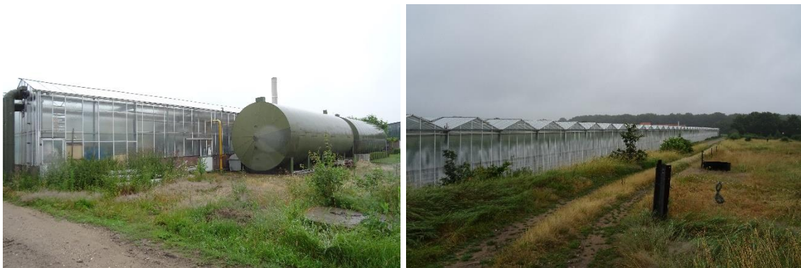
Afbeelding 3 en 4: Te slopen kassencomplex met bijbehorende bouwwerken op de kavels welke verwijderd gaan worden en onderzocht zijn op de aanwezigheid van beschermde soorten fauna. Bron: R.J.L. Bijvelds, datum: 30-06-2021
