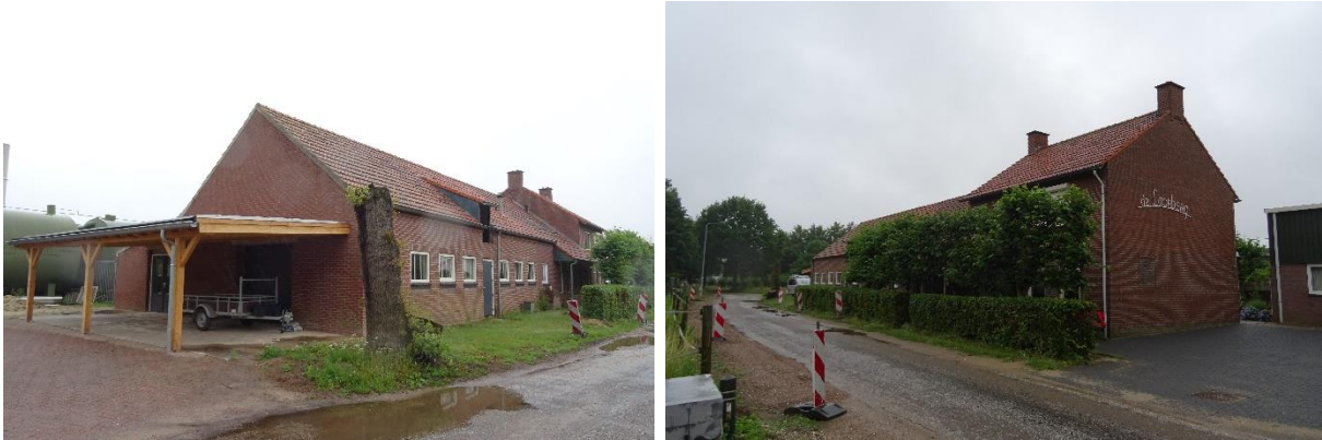
Afbeelding 5 en 6: Te behouden bedrijfswoning welke onderzocht is op de aanwezigheid van beschermde soorten fauna. Bron: R.J.L. Bijvelds, datum: 30-06-2021
